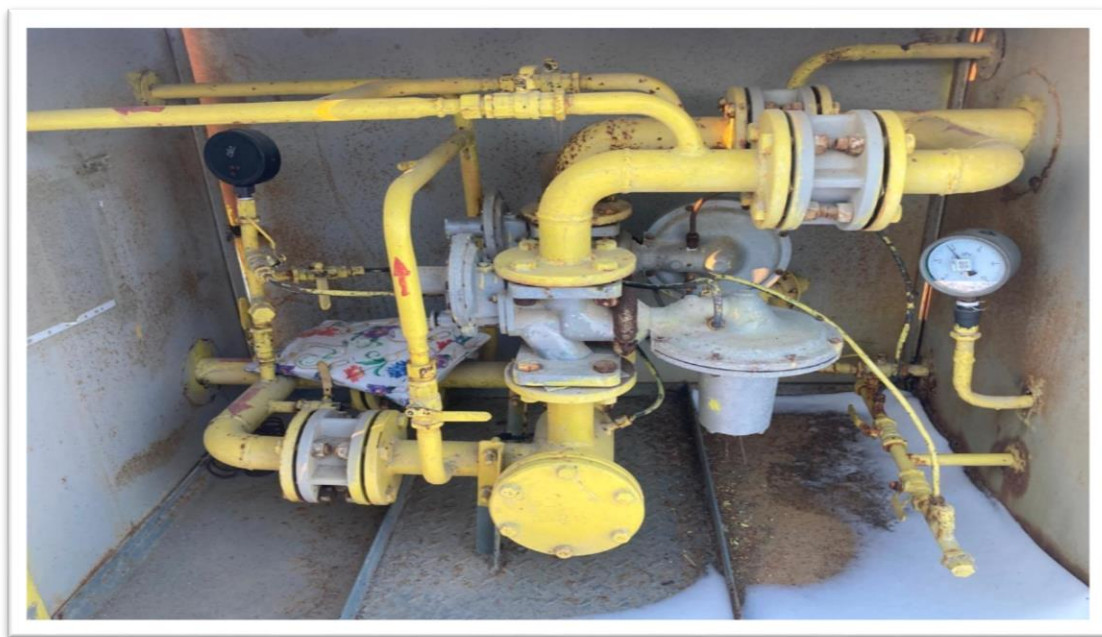
2 - сурет – ШГРП (Шкафты газ реттеу пунктері)
